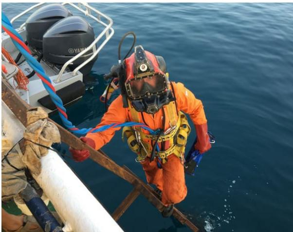
Un des équipiers n'a pas d'autre tâche que de gérer l'arrivée d'air dans le casque. Les autres présents sur la barge s'emploient, eux, à gérer le narghilé et l'utilisation des machines, pour la descente et le relevage notamment.
